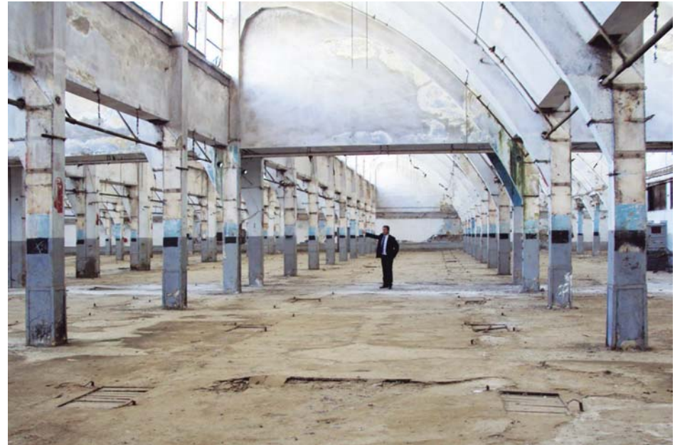
Sinema salonunun bugünkü durumu ve boşaltılan üretim alanı (altta)
